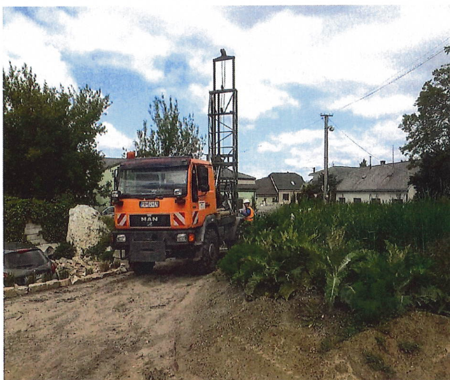
Obr. č.4: Prieskumné hlbinné vrty únosného podložia
